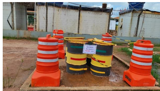
Figura 22 Material para bloqueio localizado na portaria P6
