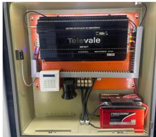
Figura 15 Módulo de acionamento e potência modelo Televale – APM.CP.V04
