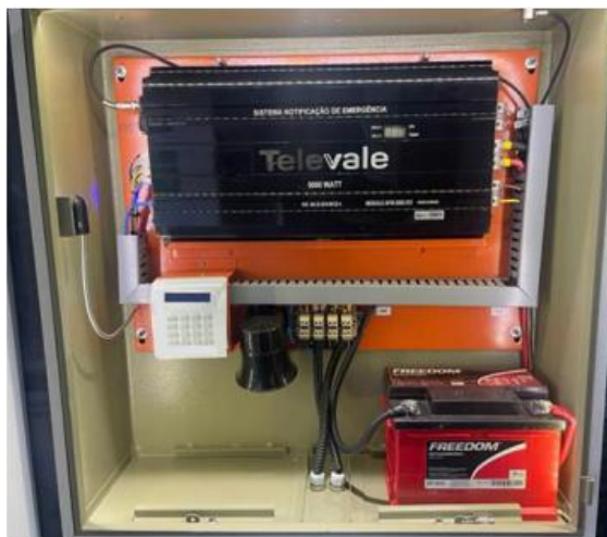
Figura 17 Módulo de acionamento e potência modelo Televale – APM.CP.V04
