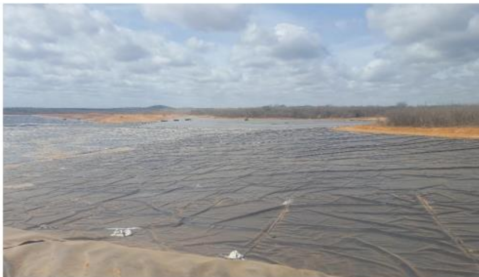
Figura 2-9– Geomembrana de PEBDL aplicada no reservatório
