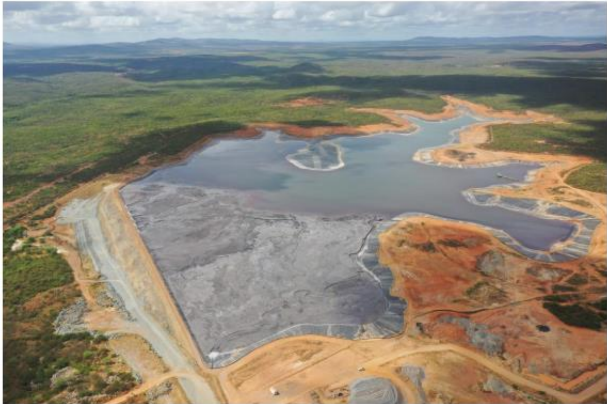
Figura 2-4 - Visão Geral da Barragem da Flotação da Unidade Santa Luz/ março de 2023
