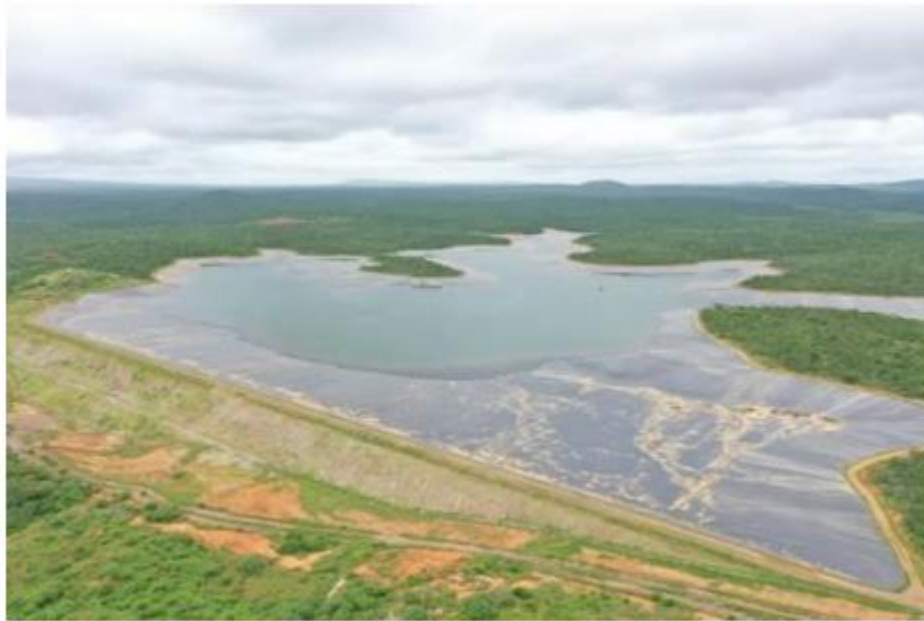
Figura 2-8 – Vista panorâmica da Barragem de Flotação. Fonte GGC Consultoria.
